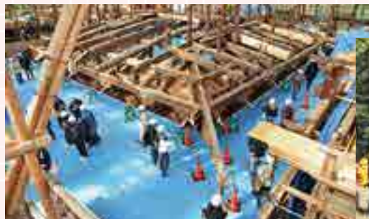
重要文化財仁和寺観音堂 修理現場公開
